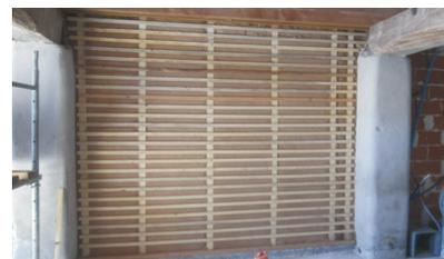
Cloison séparative en ossature bois, isolant en fibre de bois et enduit terre
